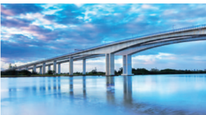
橋樑的劣化監測
